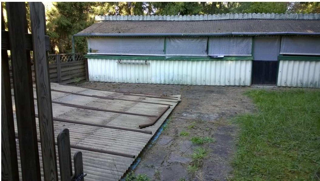
Abbildung 6.7.8. Maßnahme K6, zum Rückbau anstehende Einrichtung auf Flst-Nr. 24205.
