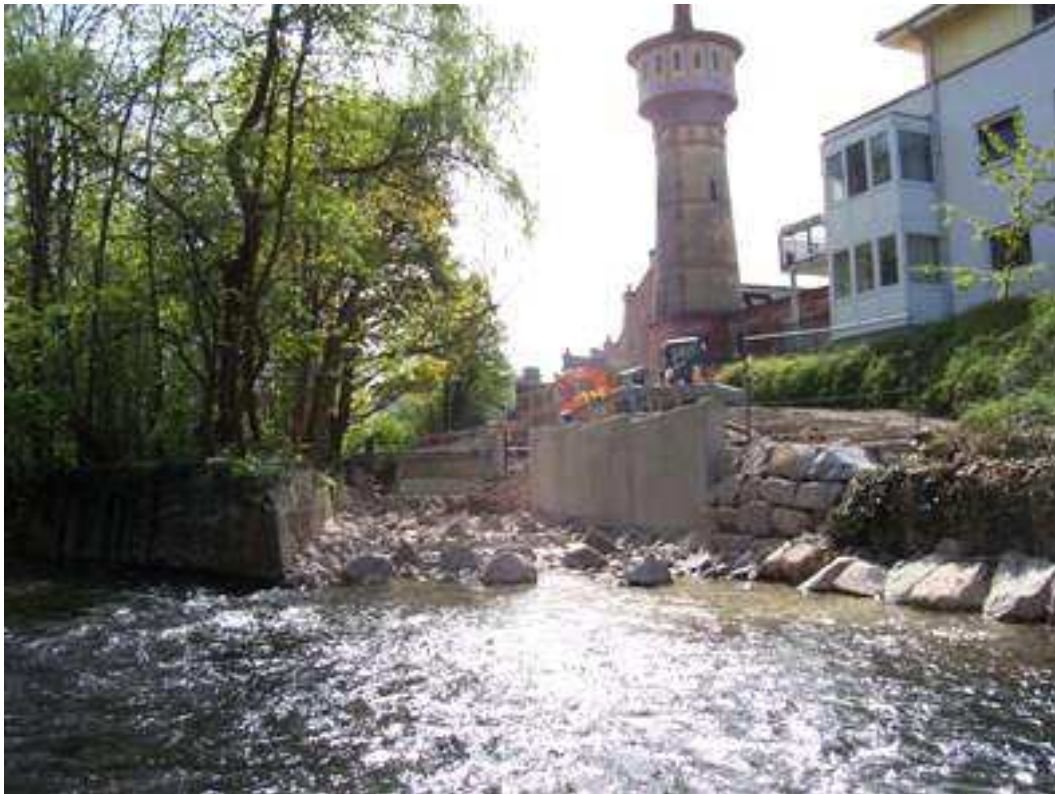
Abbildung 6.7-2. Wiederherstellung der Durchgängigkeit des Saalbachs im Bereich Schlachthof.
