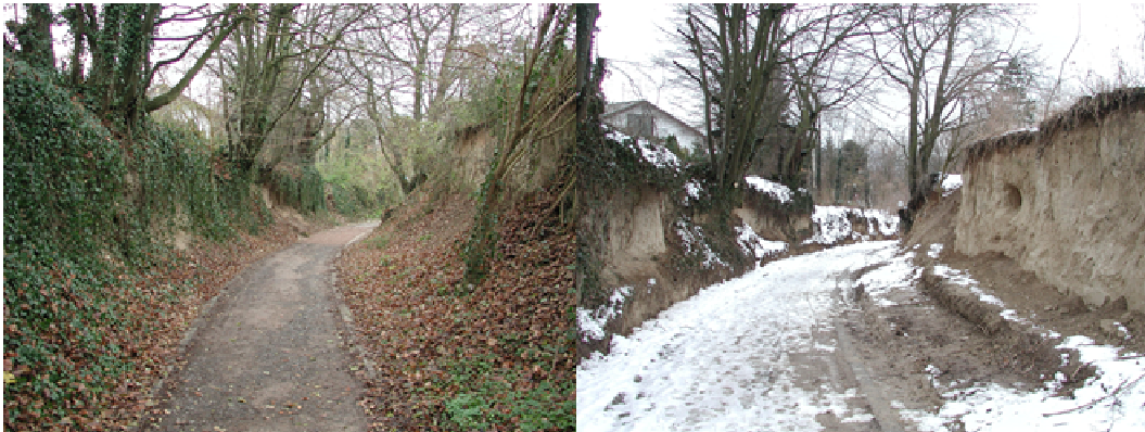
Abbildung 6.7.5. Maßnahme K5, Hohlweg "Vogelhohle" vor und nach der Sanierung.
